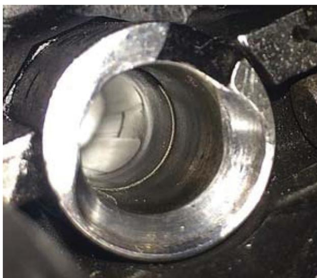
Рис. 2. Выточка в канале ствола самозарядного карабина МА-ПП-91, изготовленного на базе пистолета-пулемета ПП-91 «Кедр»
